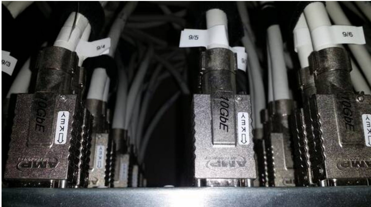
Vista posterior de las conexiones del Rack con 24 conexiones de fibra y un panel de 48 bocas a 10 Gb
